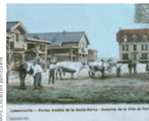
Ferme modèle, La Haute-Borne, Méry-sur-Oise, aménagée en 1900 par la ville de Paris pour l'épuration des eaux usées.
